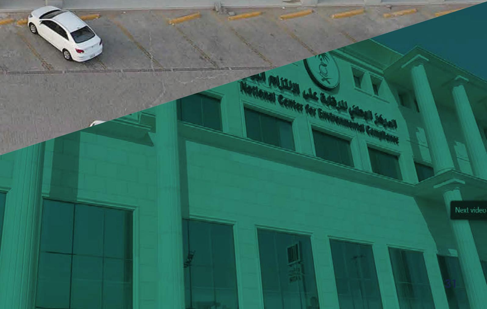
■ تنفيذ أعمال الواجهات الخارجية: تم تنفيذ الواجهات بأعلى مقاييس الجودة بنظام استرشر و تركيب زجاج مزدوج ٢٤ مم عازل للحرارة و الصوت لمساحة تصل إلى ١٨٠٠ متر مربع.
